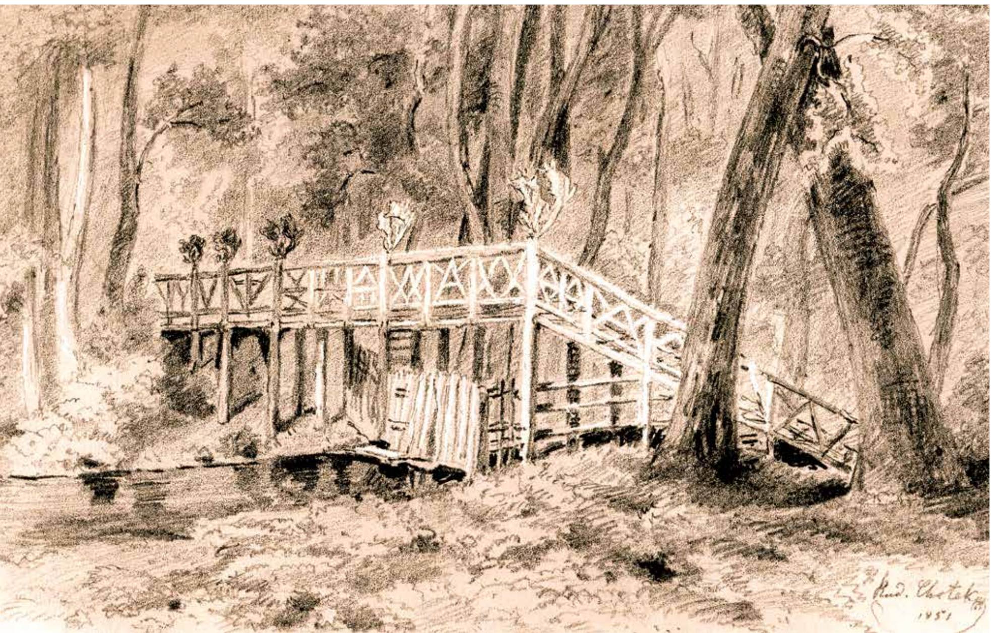
Obr. 84 Most zdobný trofejemi – daňčím parožím, patrně Lovecký (Jägerbrücke) či Divoký (Wildebrücke), přes kanál ve veltruském parku, Rudolf Chotek (1832–1894), 1851.
