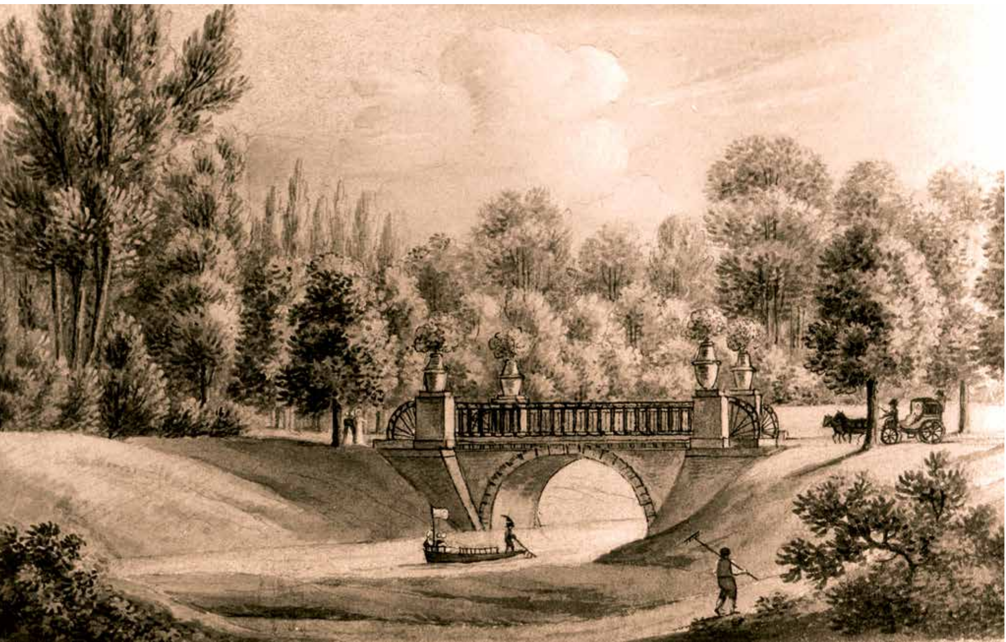
Obr. 82 Železný most (Eiserne Brücke) přes kanál ve veltruském parku, 1. třetina 19. století.
